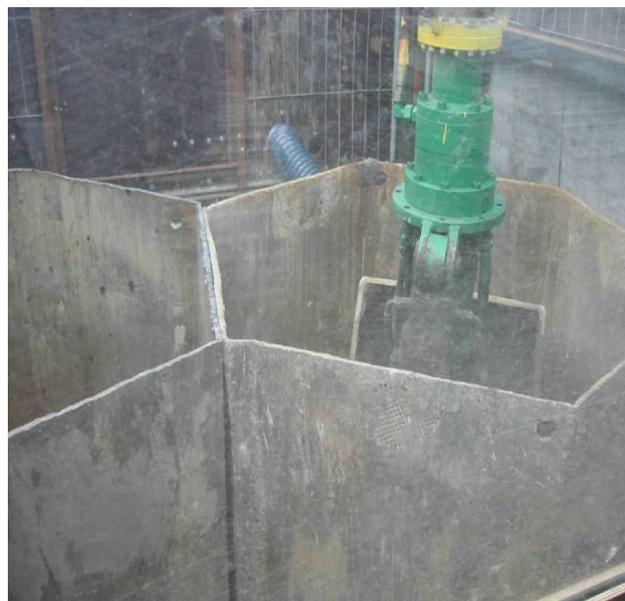
Abbildung 3: Aushubarbeiten mit dem Wabenverfahren (Bauphase 2)
