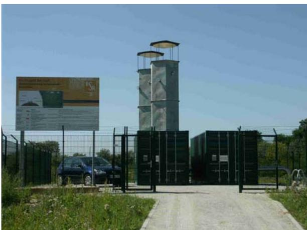
Blick auf die Verdichter- und Gasbehandlungsstation mit zwei Fackeln am Top der Altablagerung Marienfelde.
