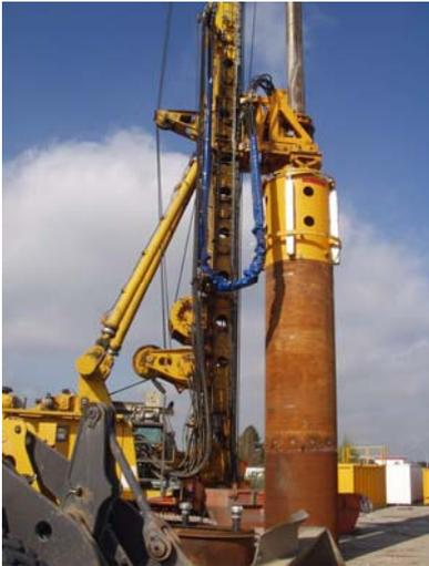
Bild 3.1: Einbringen des Mantelrohres in den Untergrund
