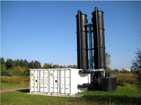
Abbildung 5: Ansicht der in 2006 mittels KatOx-Technologie modifizierten GWRA 1 „Alte Königsheide“
