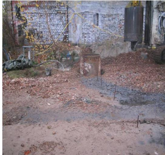
Bild 3.2: Mantelrohr bis zur Endteufe eingebracht
