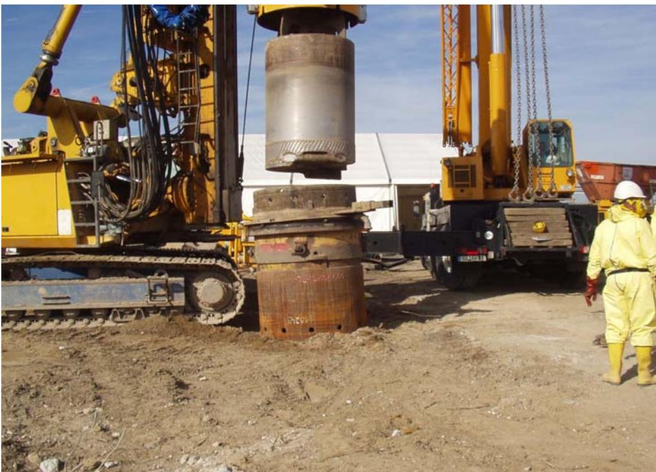
Bild 4: Einbringen der Bohrschappe in das Mantelrohr
