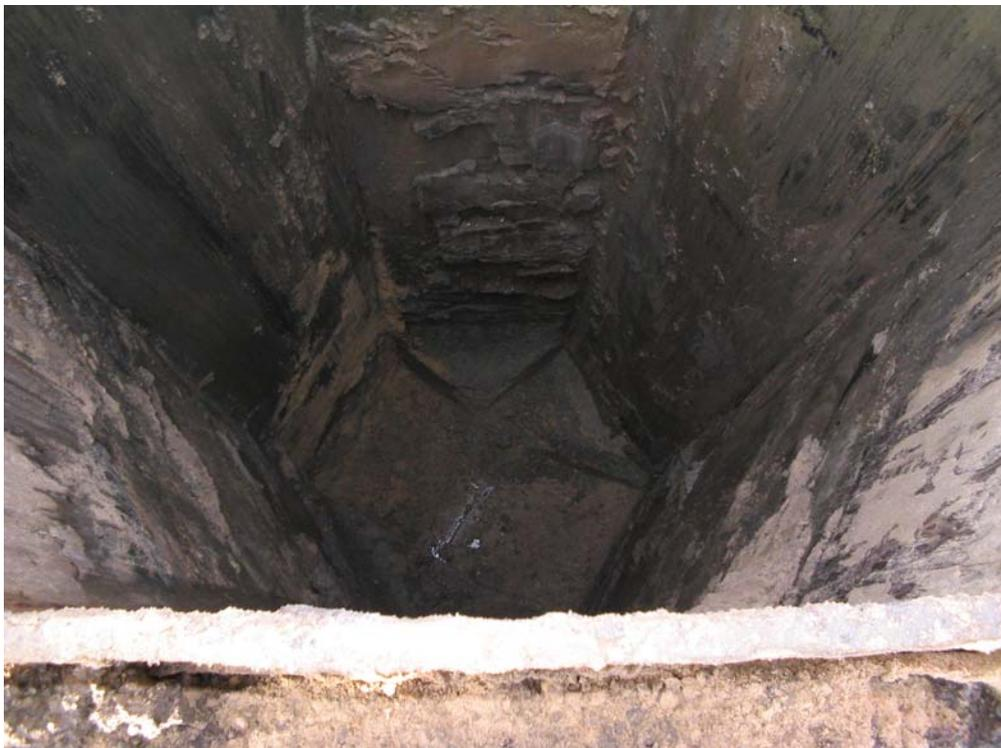
Bild 7: Blick in das Hexagonalrohr; Pfropfen an der Basis. Grundwasser noch nicht eingedrungen.
