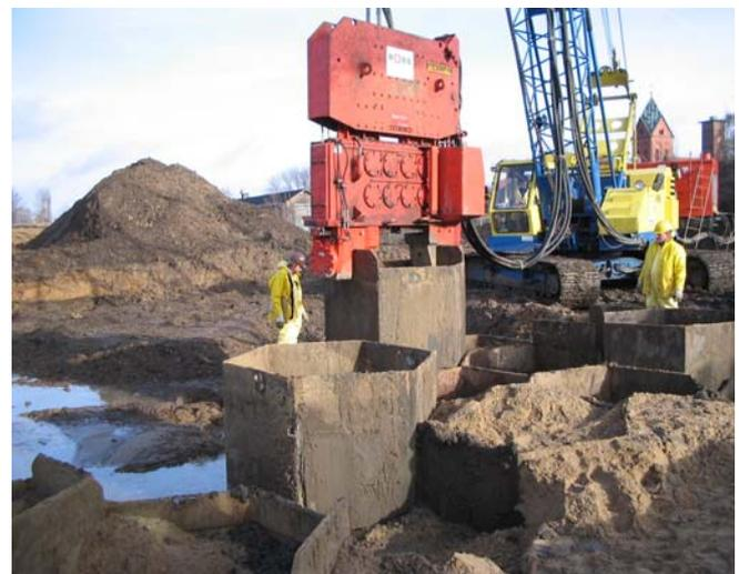
Bild 6: Ziehen eines Hexagonalelementes nach erfolgter Verfüllung im Weißbereich
