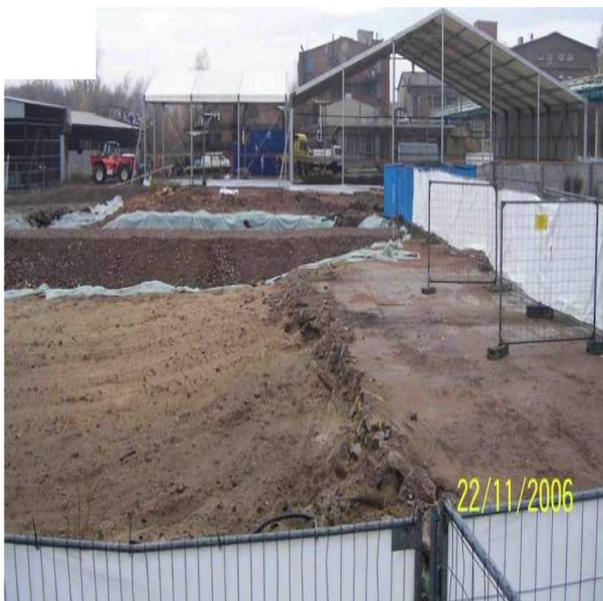
Abbildung 2: Tiefenentrümmerung des Sanierungsbereiches (Bauphase 1)
