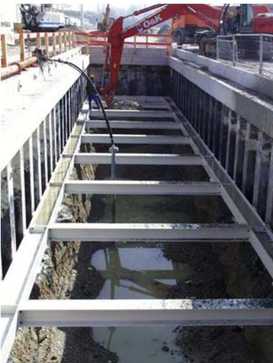
Bild 1: Spundwandkasten mit aussteifenden Profilen.
